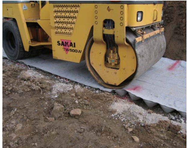
④ コニカルマット転圧状況
