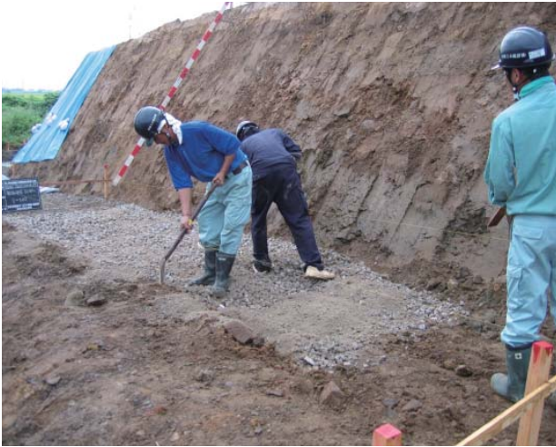
① 砕石巻き出し状況
