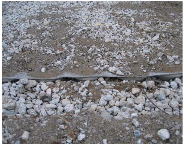
⑤ コニカルマット転圧後貫入状況
