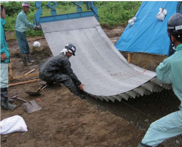
② コニカルマット敷設状況
