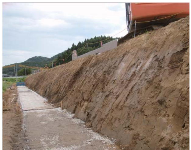
⑥ コニカルマット施工完了状況
