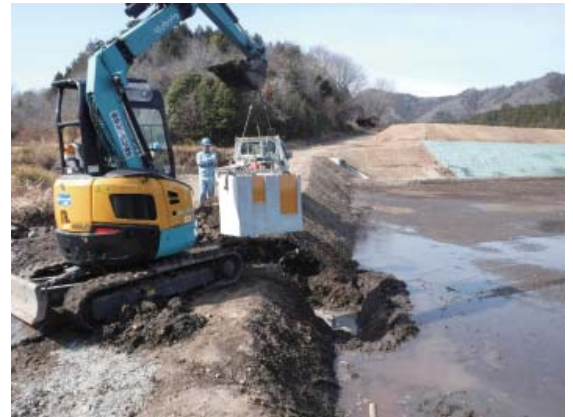
バックホウでの施工が可能
