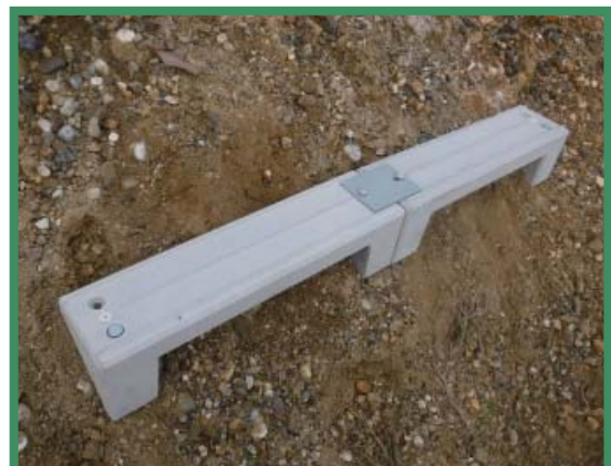
法面ステップ連結完了
