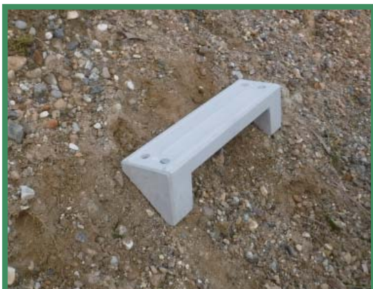
④打ち込み完了
